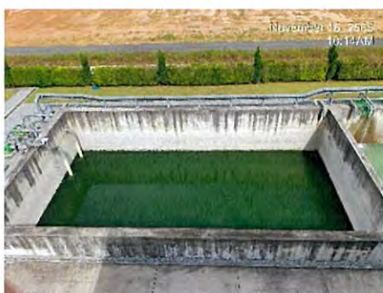
ภาพที่ 2.2-14 บ่อพักน้ำทิ้งฉุกเฉิน (Emergency Pit)
