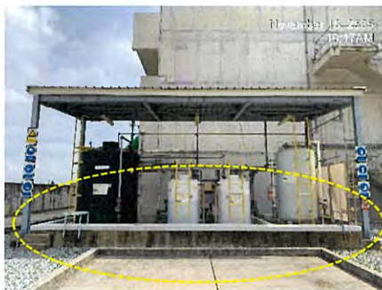
ภาพที่ 2.2-33 คันคอนกรีตรอบถังเก็บ
