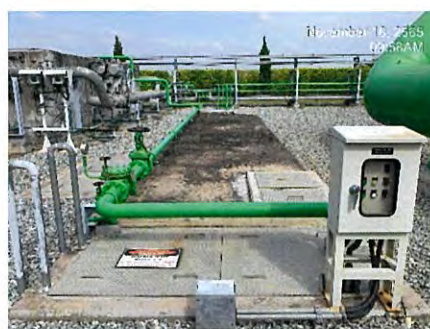
ภาพที่ 2.2-17 บ่อแยกน้ำมัน (Oil Separator)
